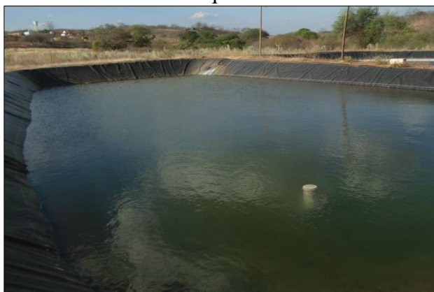
Foto 10 – Tanques de lona
