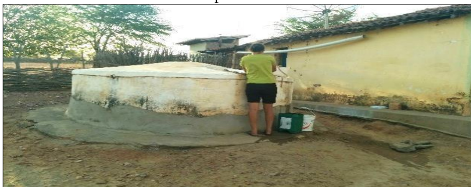
Foto 6 – Cisterna de placas na localidade Sobrado
