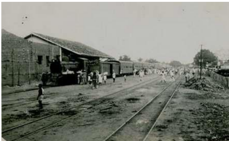
Imagem -01 Estação pátio ferroviário de Coroatá
