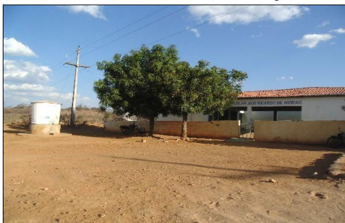
Foto 1 – Escola/ Rua sem calçamento
